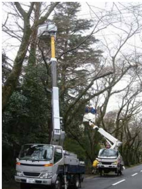
写真Ⅲ-6 高所作業車を使って手入れ作業 出典：森のボランティアのHPより引用
