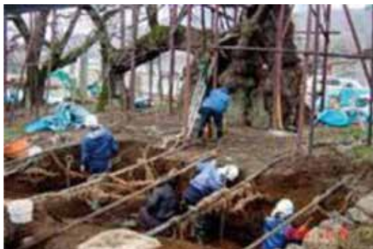
写真Ⅲ-10 根元の土の入れ替え作業
