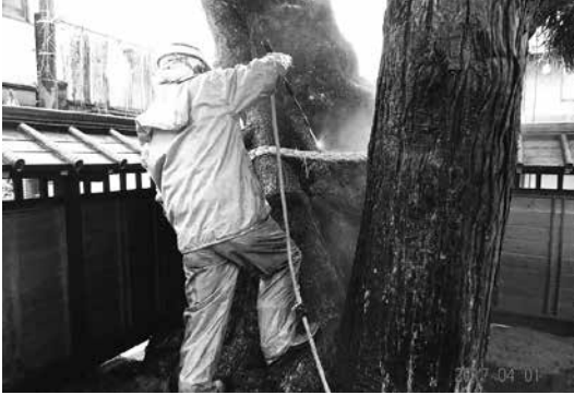
写真 18 高圧洗浄機による幹の洗浄作業 (2017年4月1日 高田雄康氏撮影)
