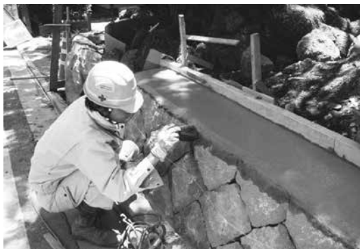
写真 15 石垣作りの仕上げ段階 (2014年6月2日 高田雄康氏撮影)
