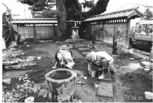
写真 19 空気管の増設作業 (2017年4月1日 高田雄康氏撮影)
