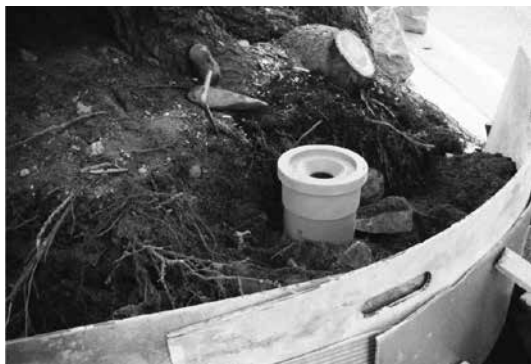
写真 14 空気管の敷設作業 (2014年5月30日 高田雄康氏撮影)
