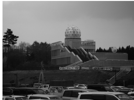
写真2 隣接公園に設置された富士山レーダードーム館
