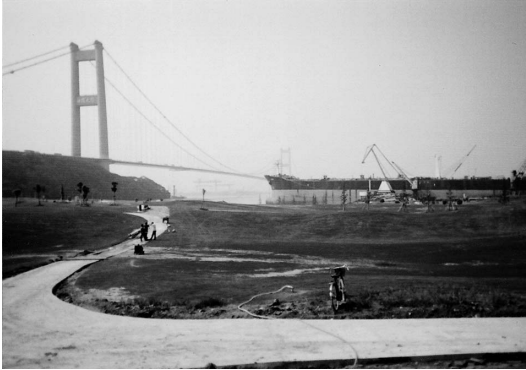
写真2 長江に架かる大吊橋と貨物船（河岸ではゴルフ場の建設が進む）（撮影=大石悠二）
