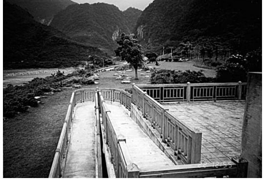
写真4 バリアフリーの整備も進んでいる (塔ロコ国立公園)
