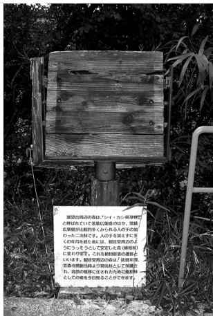
写真2 解説標識が壊れ、修理されないまま下に置かれている（笠森・鶴舞自然公園）
